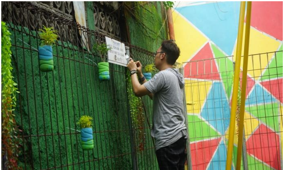
Gambar 13. Pemasangan Tanaman Rambat 9 Desember 2023
