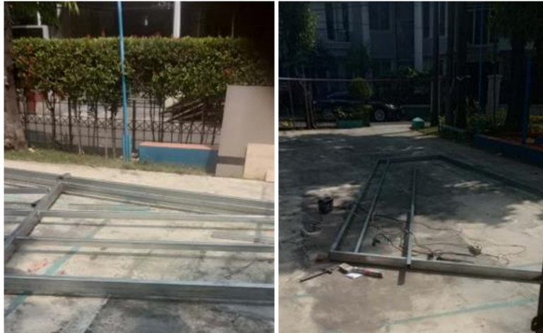
Gambar 10. Pabrikasi rangka facade (kiri) rangka utama (kanan) rangka pengisi.
