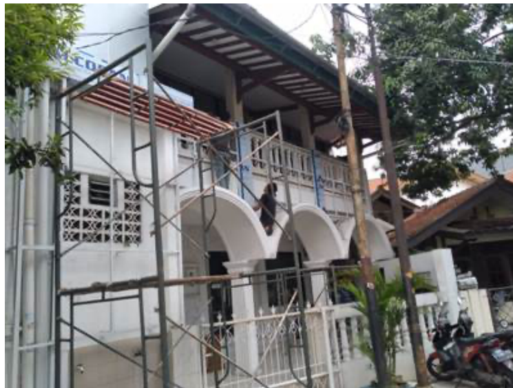
Gambar 11. Pemasangan rangka pada facade Masjid.
