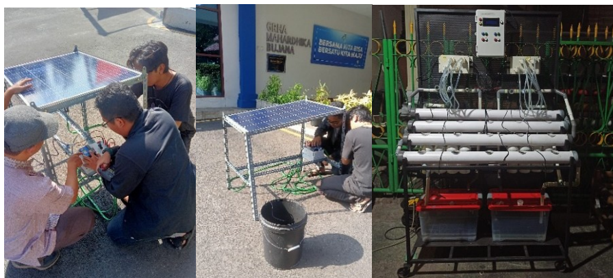
Gambar 5. Dokumentasi kegiatan pemasangan solar panel sebagai sumber daya listrik untuk pompa air hidroponik
