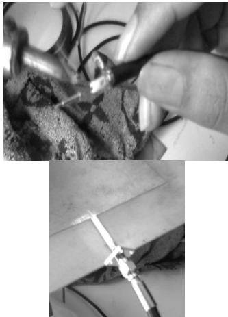
Gambar 22. Pemasangan konektor dengan kabel coaxial
