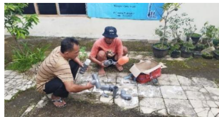
Gambar 38. Perakitan pompa hidram
