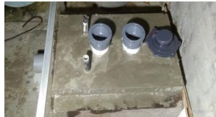
Gambar 37. Pemasangan pompa hidram pada pondasi
