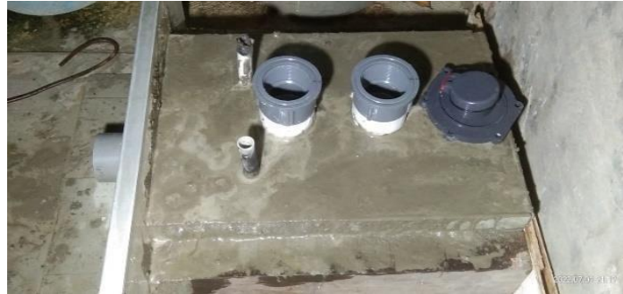
Gambar 19. Pemasangan pompa hidram pada pondasi
