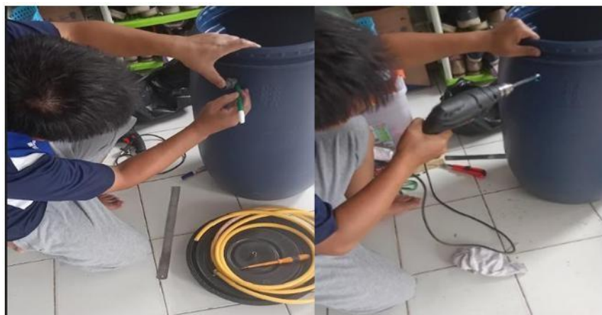
Gambar 7 Pembuatan Lubang Keluaran Biogas
