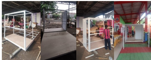
Gambar 9. Proses pembuatan cubicle portable
