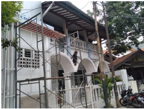
Gambar 11. Pemasangan rangka pada facade Masjid.
