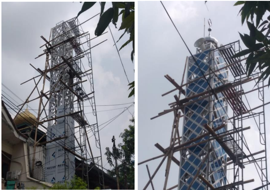
Gambar 9. (a) Pemasangan Mozaik ACP (B) Topping Off Minaret Dengan Kubah Dan Pengeras Suara.
