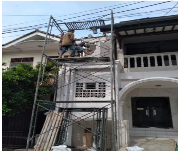
Gambar 6. Pemasangan Ikatan Rangka Dengan Pedestal Didak Beton Atap Ruang Wudhu.
