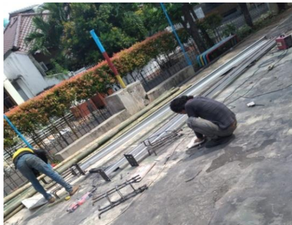
Gambar 5. Fabrikasi Rangka Utama Minaret.
