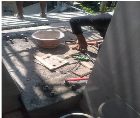
Gambar 7. Pemasangan Stek Dan Cor Balok.
