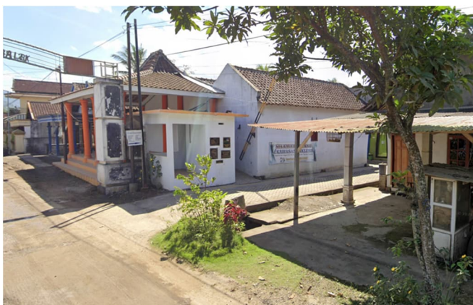
Gambar 1.1. Pintu Masuk Area Perumahan Inklusif
