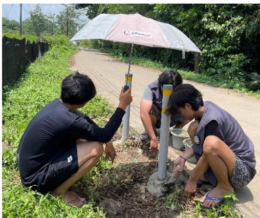
Pemasangan delineator
