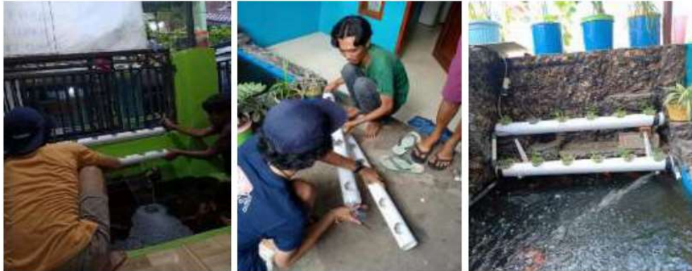
Gambar 6. Merupakan Hasil Dokumentasi Instalasi Perangkat Hidroponik.
