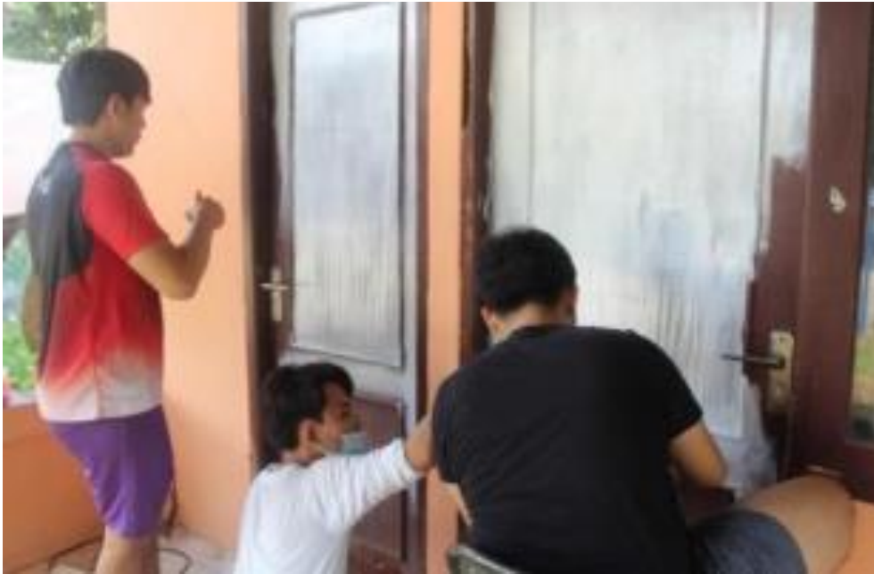
Gambar 5. Pengecatan Dinding Posyandu
