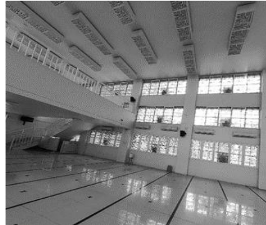
Gambar 29. Dinding Kaca, Ventilasi Alami
